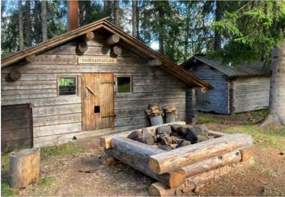
Bild 17. Kråkbackskojan är en varmbonad variant av eldpallkojan. I bakgrunden syns övernattningskojan. Foto: C. Karlsson 2021
